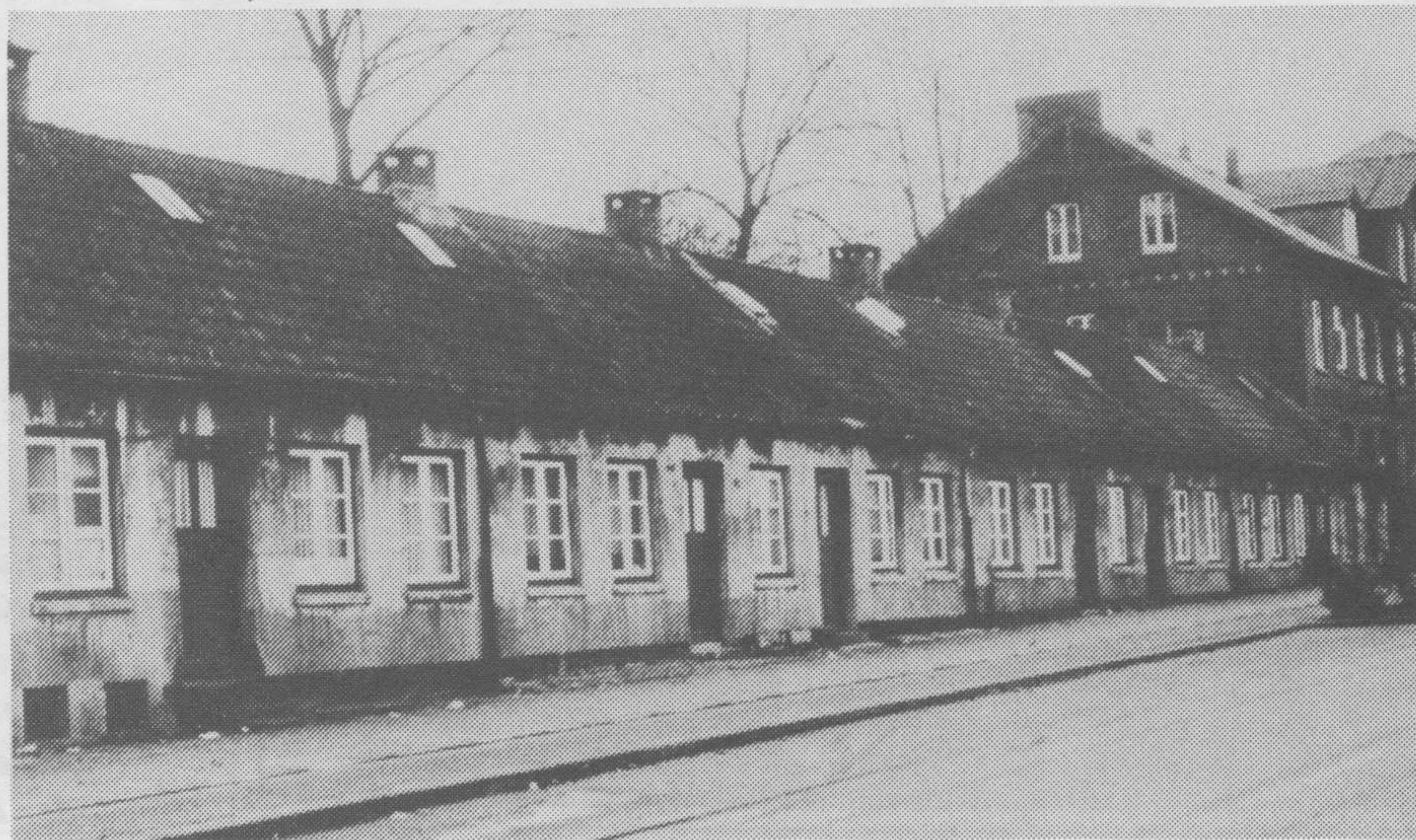
1880 begann die Jute, für ihre Arbeiter Werkwohnungen zu schaffen, wie hier in der Möllner Landstraße
